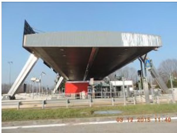
(mantovana laterale ammalorato)
