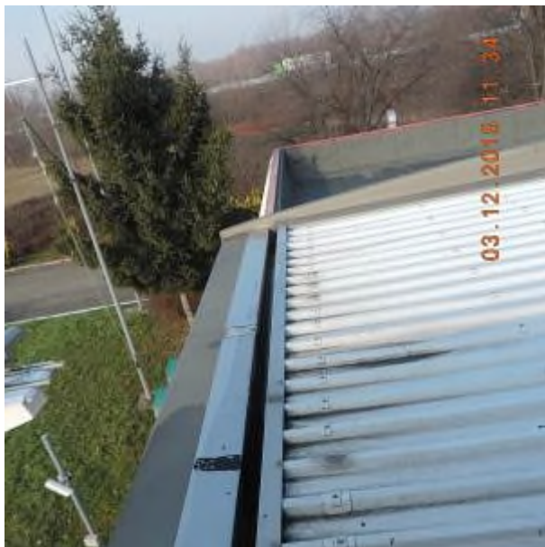
(mantovana laterale ammalorato)
