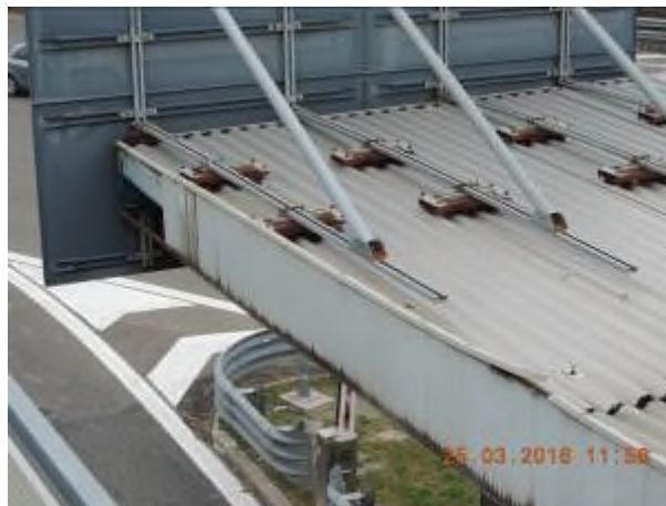
(mantovane ammalorate )
